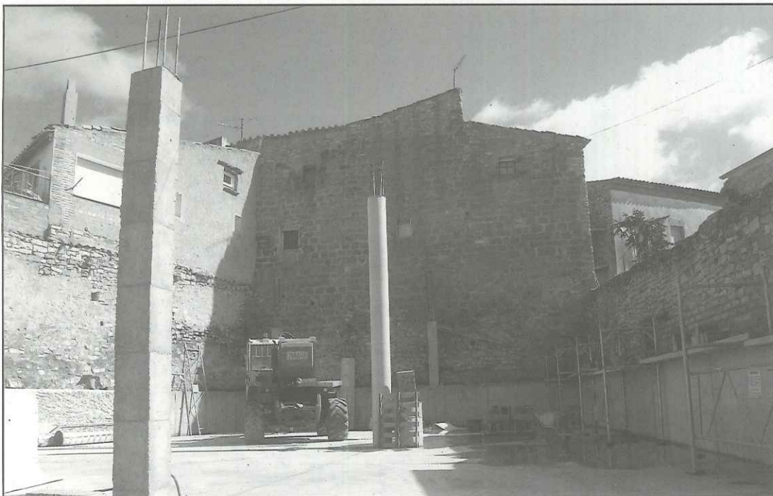
Aspecte actual de les obres del nou magatzem de Tarroja
