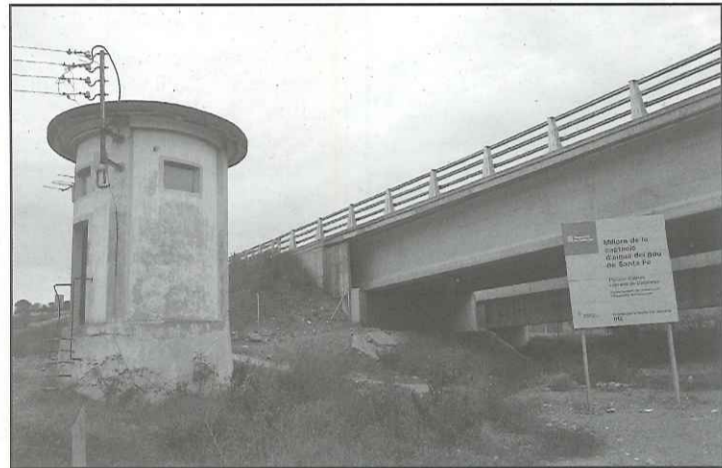
El pou de Santa Fe on s'han realitzat les obres de millora
